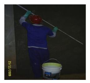
4) Aspectos das alvenarias já regularizadas (Fotos), esta fase é muito importante, pois a ausência de regularização, compromete o sistema de impermeabilização, visto que no assentamento dos blocos, podem ocorrer retrações normais dos materiais cimentícios e estas por sua vez, formarem caminhos livres para a percolação de água.
