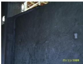
3) Argamassa de regularização impermeável NBR-12190 – ABNT traço volumétrico cimento : areia (1:3) com 02 litros de aditivo hidrofugante MSET 1 - BAUTECH e 02 pacotes de Fibras de polipropileno 100 gramas Polymassa Antitrinca para cada saco de cimento 50 Kg.
