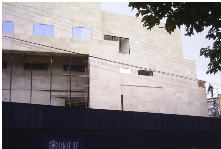
Fotos da fachada instalada.
