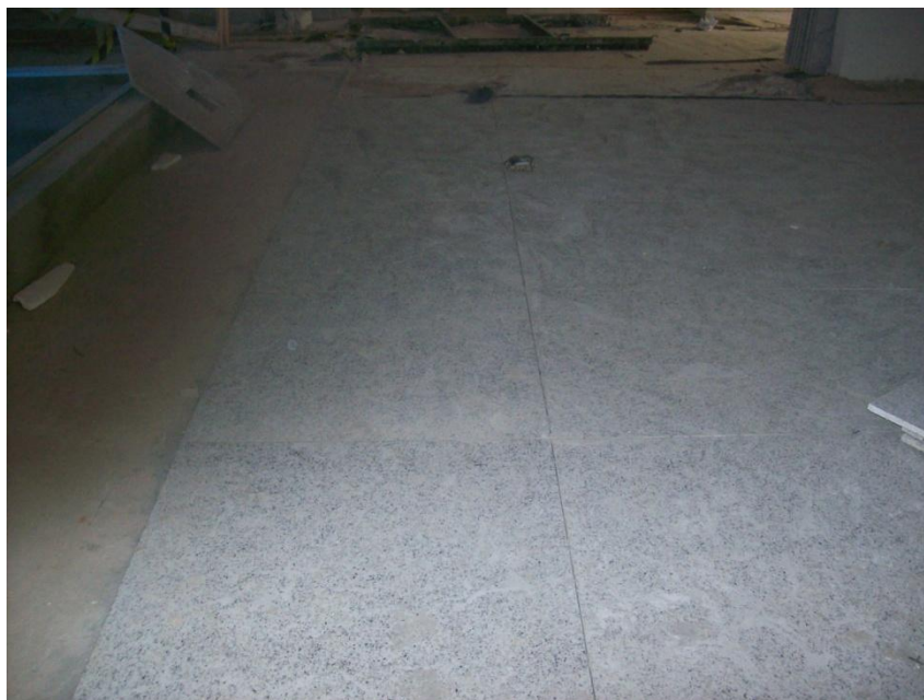
Fotos do piso durante o assentamento.
