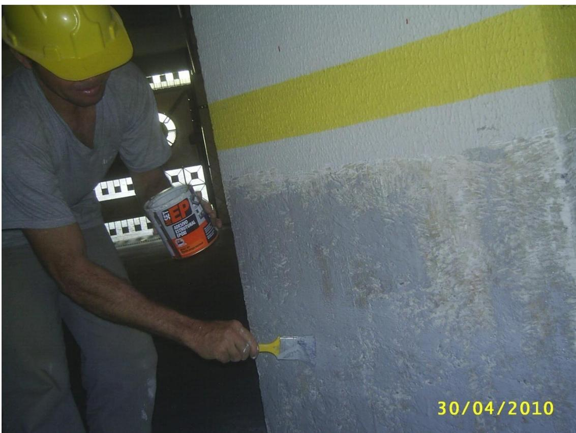
**5) Feita a aplicação do adesivo epóxi, MSET EP ADESIVO, encamisar os pilares com caixotes, para enchimento com GROUTE BAUTECH.**
