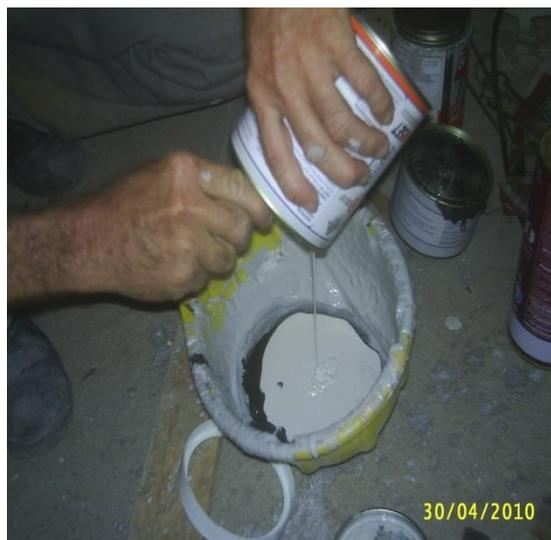
**4) Após a mistura, aplicar com trincha o adesivo epóxi, MSET EP ADESIVO, no local onde haverá o reparo.**
