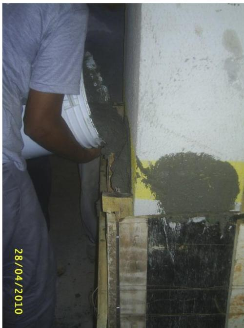
**8) Feito enchimento, aguardar 24 horas para tirar as camisas de madeira, ( deverá ser aplicado desmoldante BAUTECH OL nas madeiras, para melhor desforma ), e proceder a finalização com cura úmida por um período de 1 dia.**
