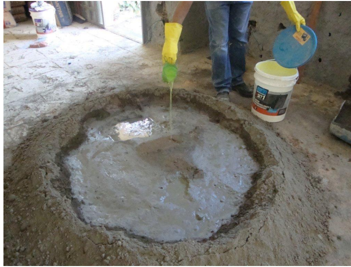
Adição de 02 litros de MSET1 – BAUTECH para cada Sc. de 50 Kg de cimento
