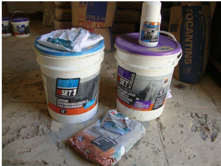
Produtos na obra
