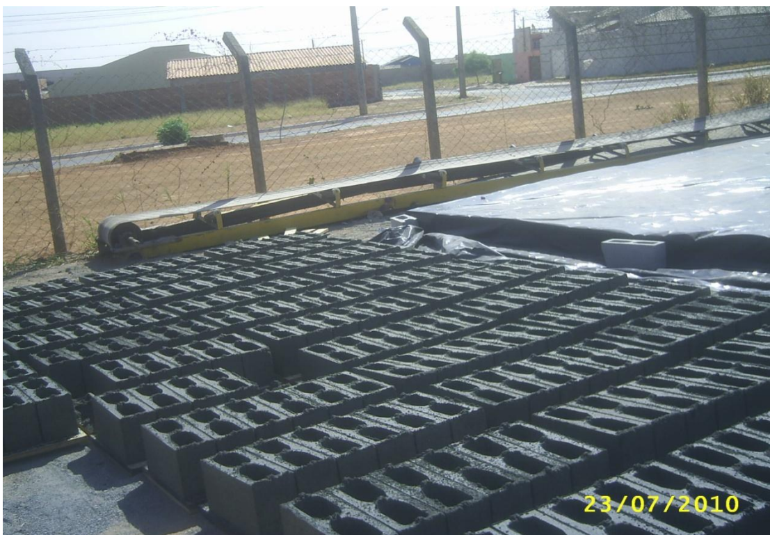
4) Foto tirada no canteiro da obra, após o processo de fabricação.
