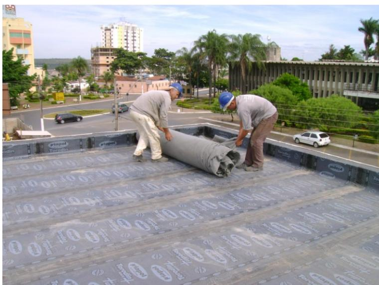
**3) Bidim RT-8 sendo estendido , horizontalmente sobre a manta asfáltica**
