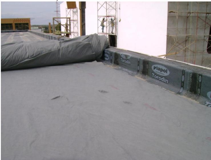
**4) Aplicação finalizada, onde o Bidim RT-8 cumpriu a principal função para o qual foi especificado, que era de camada de amortecimento e maior resistência aos esforços de tração durante a execução da proteção mecânica de argamassa com a finalidade de evitar danos ao filme impermeabilizante inclusive durante a execução da mesma.**
