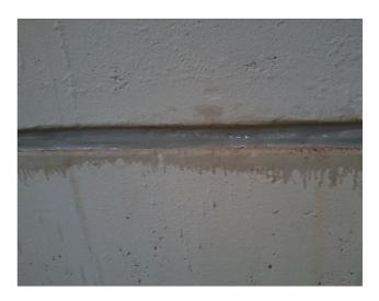
4) Procedimento executado também no lado externo, acrescentamos uma pintura impermeável contra batidas de chuva a base de resina acrílica super flexível e impermeável de cor branca, que previne manchas de umidade e bolor mantendo a superfície protegida além de reduzir também a temperatura interna por reflexão dos raios solares.
