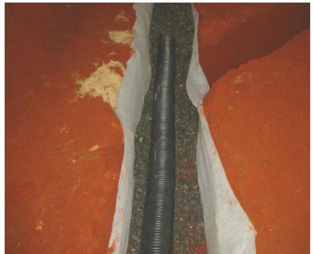
**5)** Costurando o Bidim com fio de poliéster com sobreposição mínima de 20 cm e aterro de cobertura da trincheira drenante;
