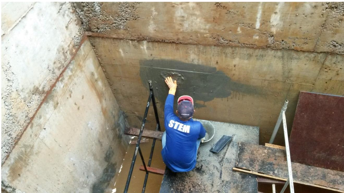
4) Aplicação de **CHEM CRETEX 600 C** sobre a região onde foi executado o tamponamento, a mistura foi mecânica com hélice acoplada a furadeira elétrica a aplicação com ferramenta de cerdas (broxa).
