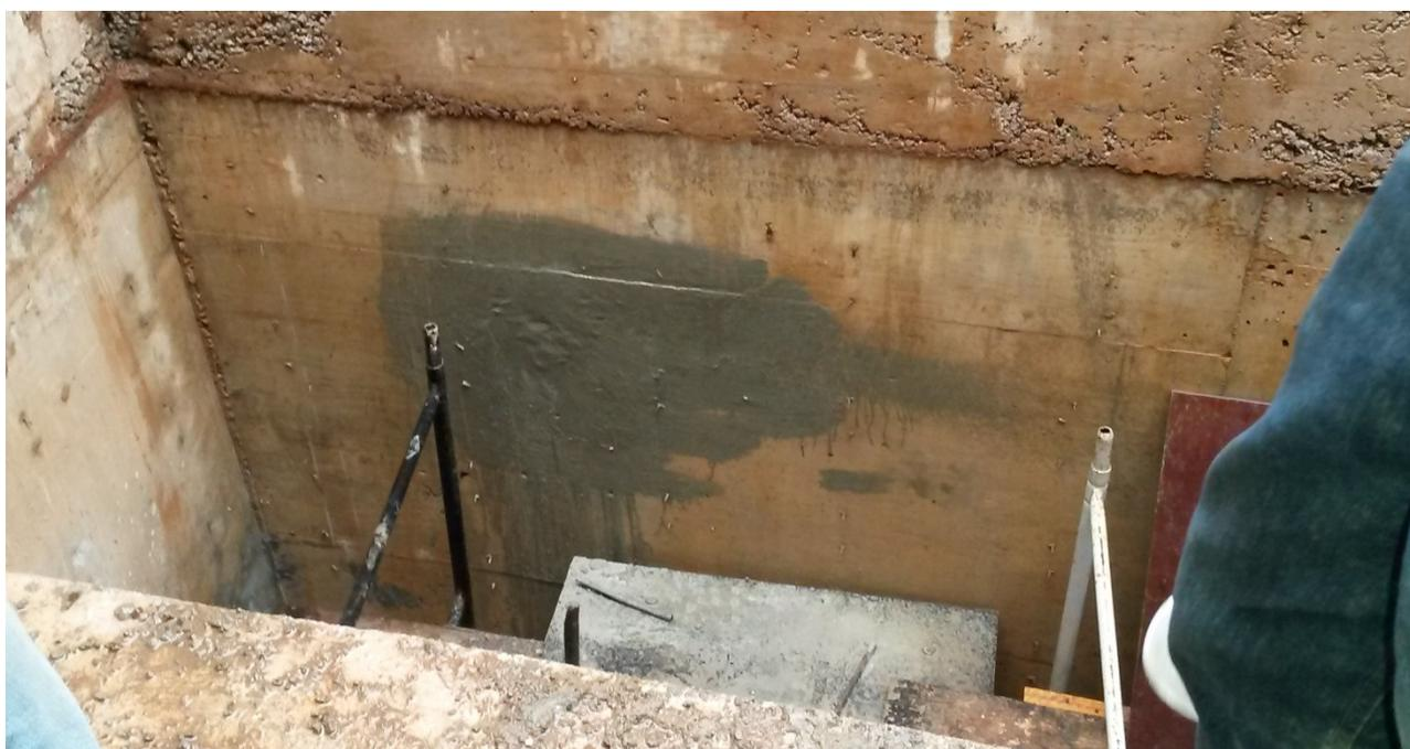
Após a contenção dos jorros vivos, a estrutura recebeu a aplicação de cimento polimérico BAUTECH TOP e foi regularizada com revestimento de reboco composto por cimento e areia.
