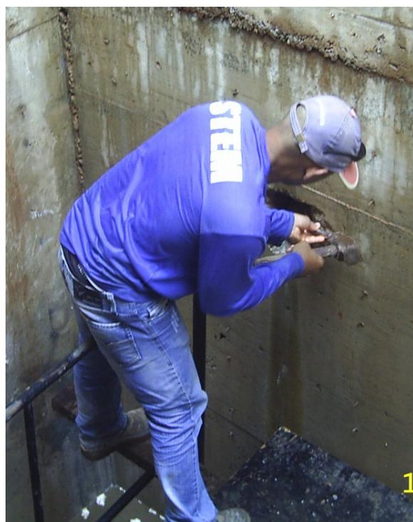
A aplicação do **Chem Cretex Plug** para o tamponamento, foi executado diretamente sobre o jorro vivo da água vinda do lençol freático, com a abertura de cavidade no concreto para aumentar a área de ancoragem no formato de “Cauda de Andorinha” e o material foi comprimido manualmente contra a estrutura até sua cristalização, usando EPI (luvas de borracha), em torno de 120 segundos, na sequência, foi aplicado com broxa o impermeabilizante **Chem Cretex 600 C**, como finalização do sistema.
