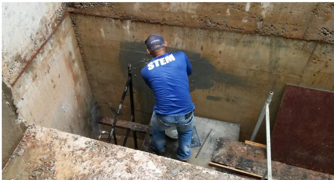
Foi instalado um dreno provisório com mangueira de polietileno, para alívio de pressão enquanto era executado o tamponamento e posteriormente removido.
