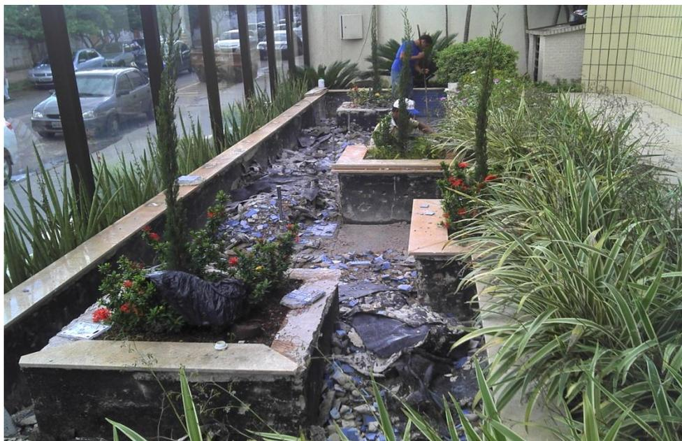
**1)** Após a remoção da manta asfáltica existente no espelho d'água, foi executada ponte de aderência com **Mset Fix C** e regularizada com argamassa impermeável conforme NBR-12190 – ABNT traço volumétrico cimento : areia ( 1 : 3 ) com aditivo hidrofugante - **MSET 1** e Fibras de polipropileno **Polymassa Antitrinca**.
