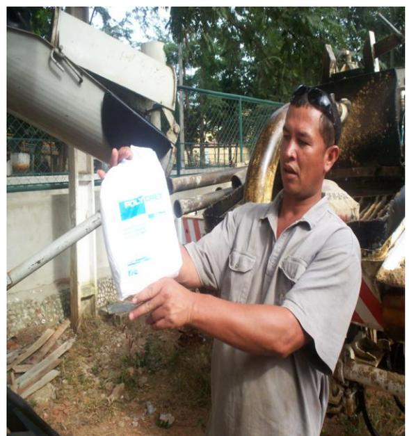
As Fibras são lançadas com a própria embalagem porque a mesma é hidrossolúvel, deixar tempo de mistura por 5 minutos até que as fibras estejam uniformemente distribuídas no concreto.
