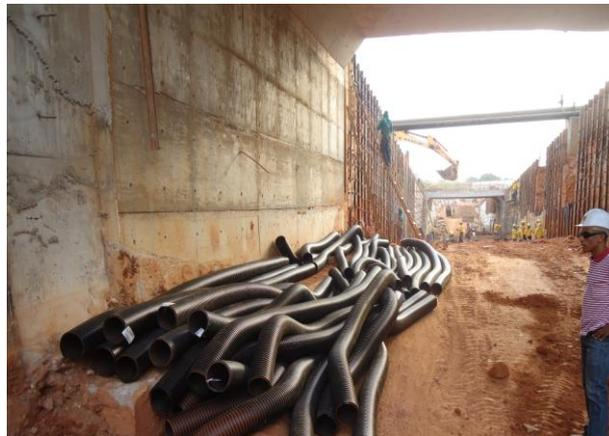
2) Colocação dos tubos KANANET dentro das valas abertas, estando os mesmos posicionados no interior da vala, para a separação granulométrica entre os grãos de solo e a camada de brita, foi utilizado geotêxtil Bidim, com a finalidade de evitar a colmatação do dreno por partículas do solo.
