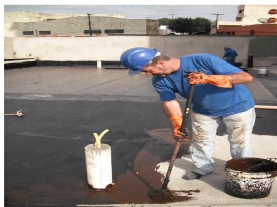
Após a secagem do primer foi feito o alinhamento da manta de acordo com o requadramento da área, executando a colagem no sentido dos ralos para as cotas mais elevadas. Com o auxílio da chama do maçarico de gás GLP, foi feita a colagem das mantas obedecendo a sobreposição de 10 cm e o biselamento para perfeita vedação.
