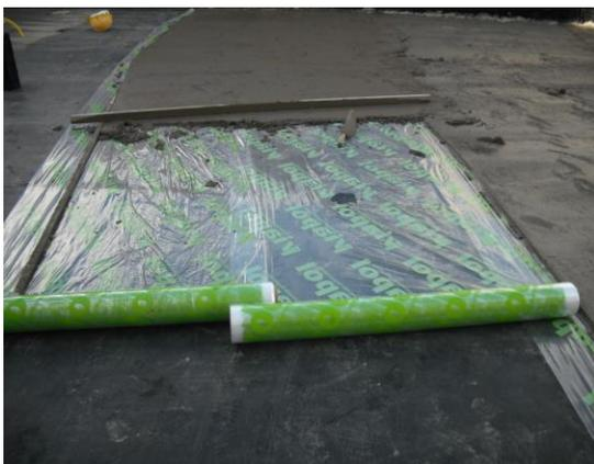
Fotos tiradas no canteiro de obras durante a execução desses procedimentos de aplicação da manta asfáltica.
