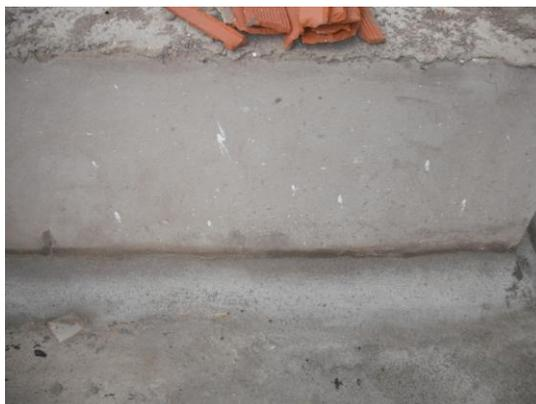
Ao redor dos ralos, foram criadas leves depressões de 10 mm num raio de 40 cm com bordas chanfradas, para o nivelamento da impermeabilização sobreposta nesta região.
