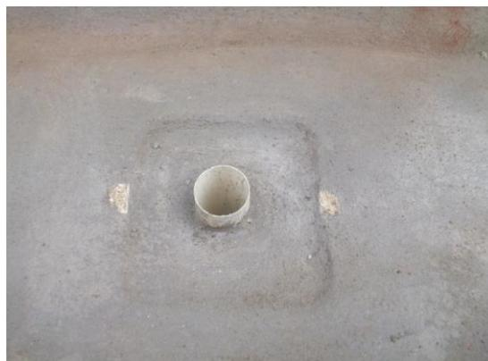
Após a cura da argamassa de regularização foi aplicada uma demão de primer asfáltico base d'água ECOPRIMER com o auxílio de uma broxa para caiação ou rolo de lã de carneiro.
