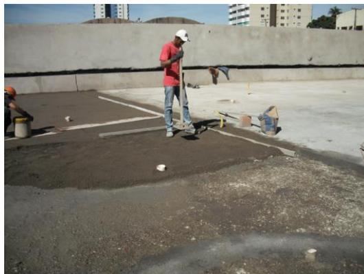
Nas áreas verticais, foi feito corte do revestimento existente 30 cm acima do nível do piso, para embutir filme impermeabilizante, nas floreiras o corte teve um acréscimo de mais 30 cm acima do nível do solo que será utilizado no plantio das mudas.
