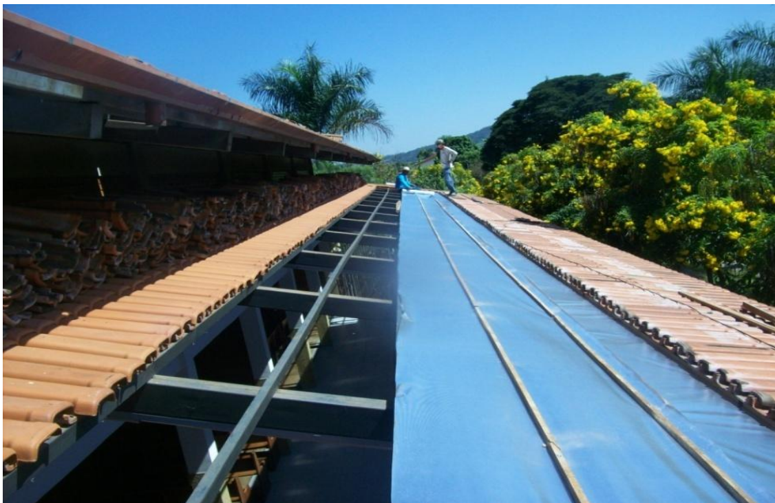
a) Face aluminizada voltada para a face inferior das telhas
