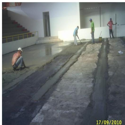
**5) Quadra já regularizada com argamassa de cimento e areia aguardando somente a aplicação do revestimento final Paviflex.**
