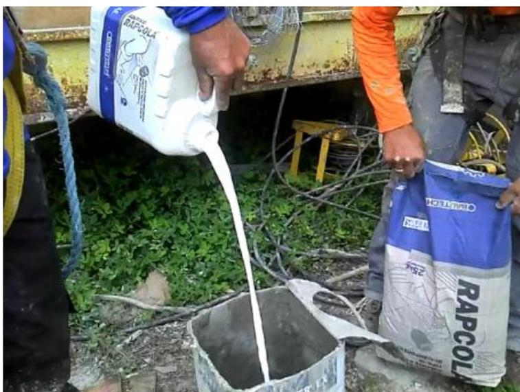
Adicione a Rapcola 24 horas lentamente enquanto é executada a mistura com hélice acoplada a furadeira, até que se forme uma massa homogênea e pastosa.
