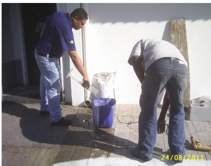
**4) Mistura mecânica do material utilizando hélice B-1 e furadeira elétrica com mandril de ½", sempre adicionando o pó sobre o líquido**
