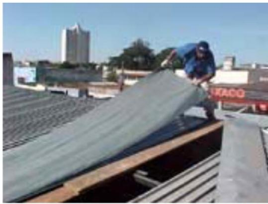
Após a retirada da telha passar um adesivo de contato para aderência do Bidim à telha, aplicando uma camada sobre o Bidim e outra sobre a telha. Após aplicação do adesivo aguardar 15 minutos para a evaporação do solvente.
