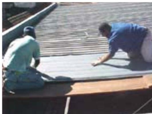
Colocar a telha novamente e retirar prováveis sobras nas bordas da telha de Bidim.
