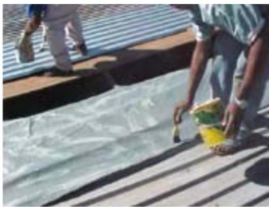
Em seguida aderir a telha ao Bidim cuidadosamente verificando se os dois materiais se aderiram por completo.
