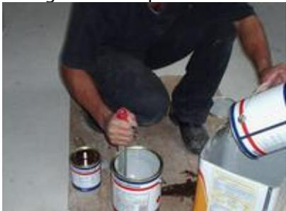
2 - Adicionar o componente A ao componente B
