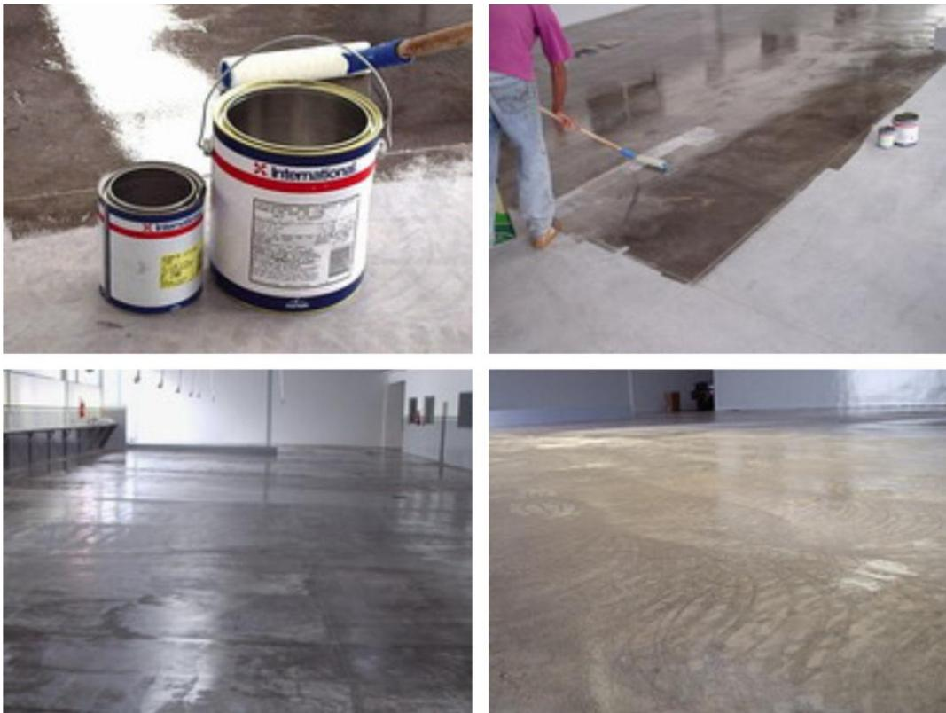
3 – Primeira da demão da tinta de acabamento Interseal 211 com 20% de diluição de solvente para epóxi GTA 220
