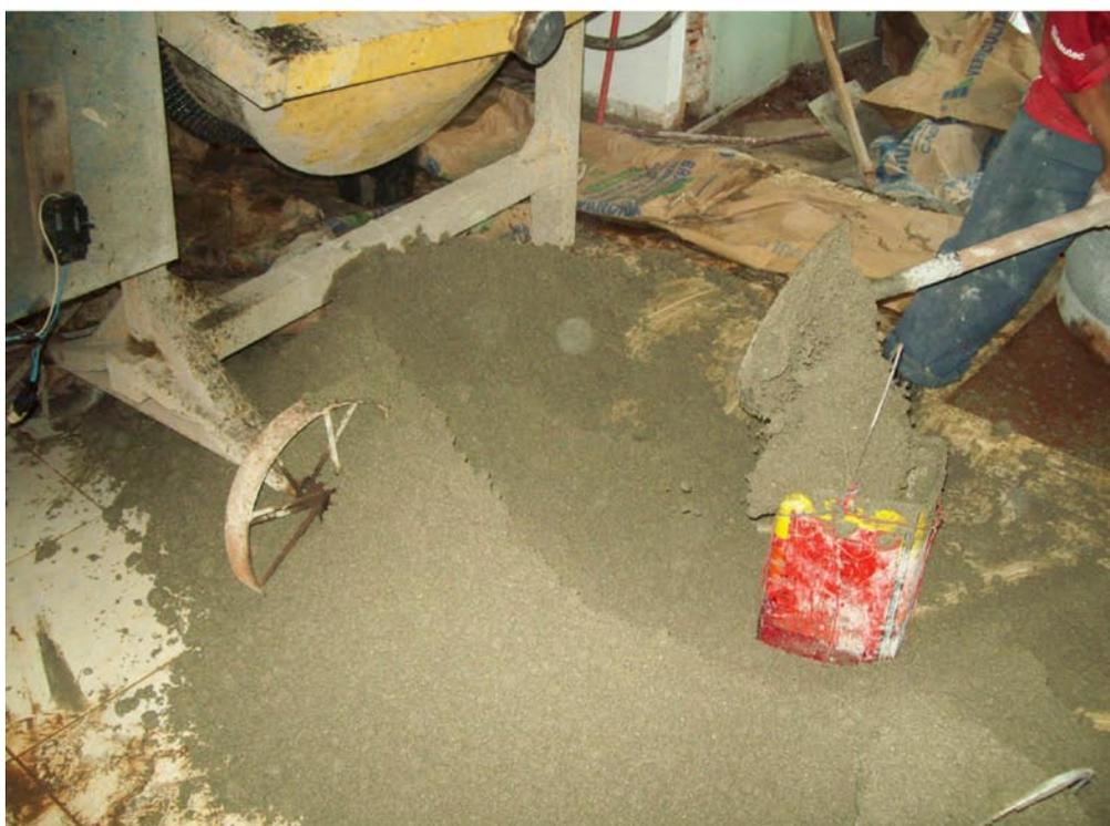
4) O acabamento foi efetuado com régua de alumínio e desempenado com desempenadeira de madeira. A cura foi feita com água por três dias. Após cura mínima por sete dias, o enchimento leve (argamassa de vermiculita) deverá receber proteção mecânica de argamassa de cimento e areia (1:3) com espessura mínima de 40 mm para receber tráfego de pedestre (leve).
